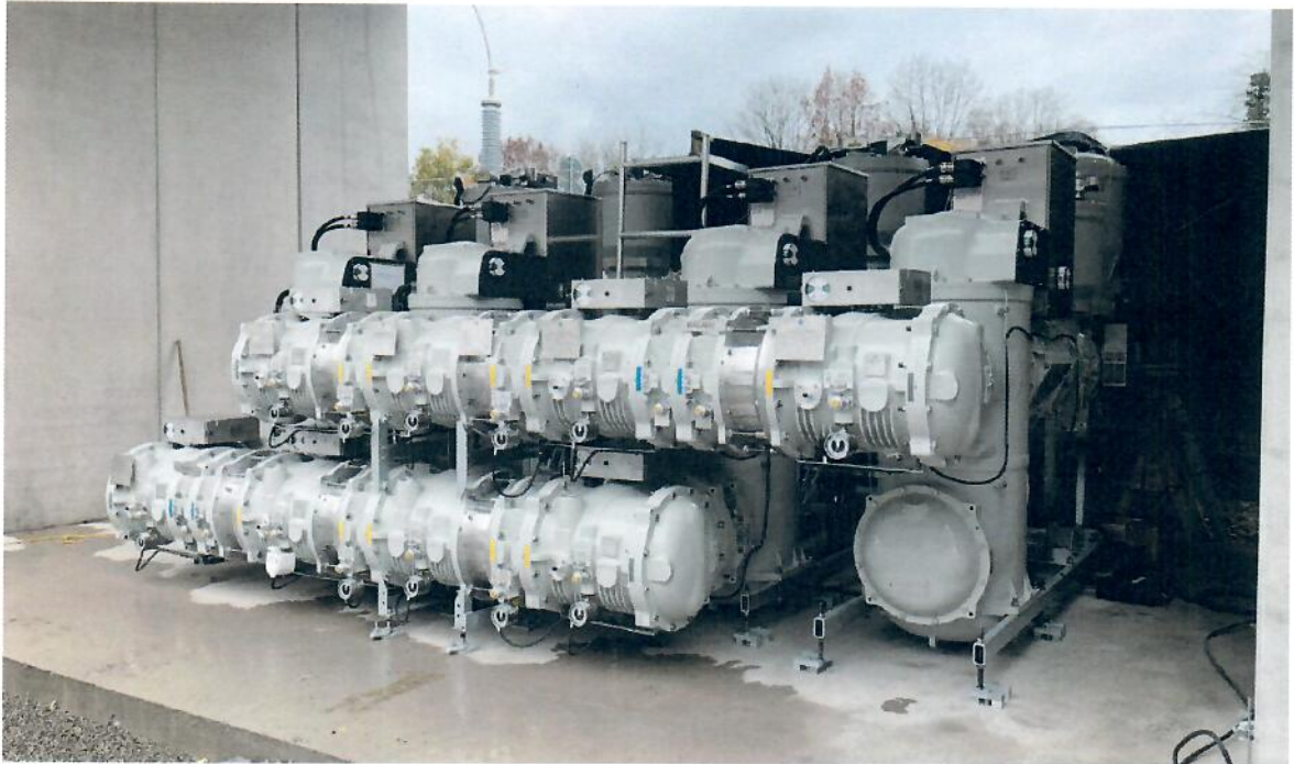
Bild: GIS -Schaltanlage
